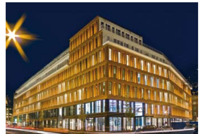
Lichtgestaltung mit Vorbildcharakter: die OEC-Beleuchtung des Angerhofes in München spart 93 Prozent Strom.
